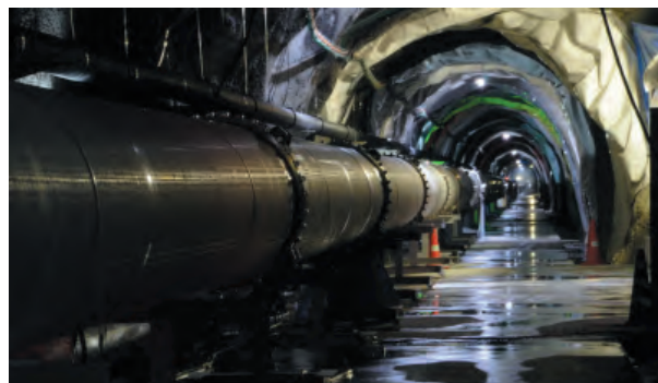
KAGRA の真空ダクト Credit: 東京大学宇宙線研究所
